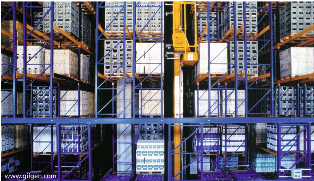
Kuva 4: Laseranturit kiinnitetään vaunujen syöttölaitteiden mastoihin.
